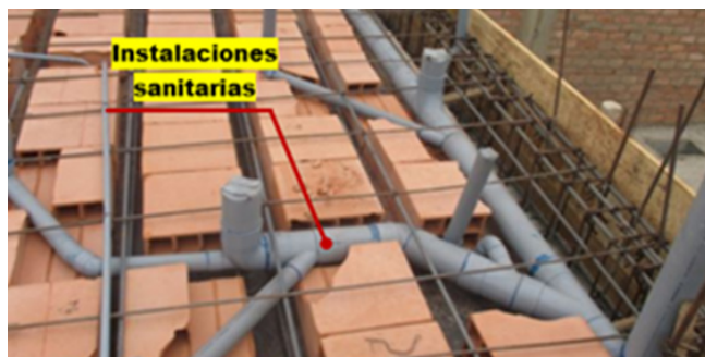
Ilustración 6 Losa Aligerada
