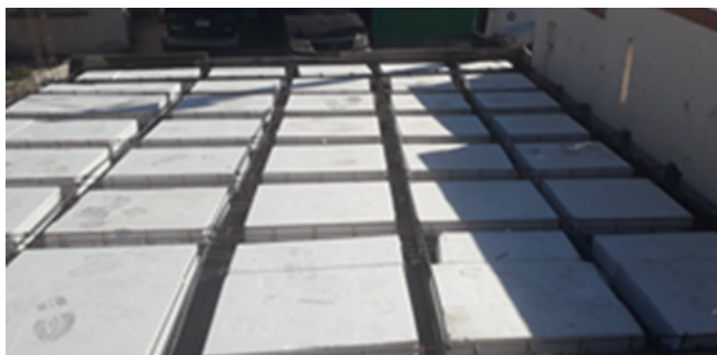
Ilustración 5 Losa nervada
