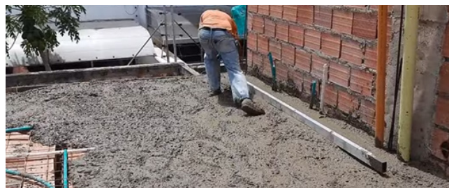
Figura 11 Enrase de la placa utilizando boquillera y palustre.
