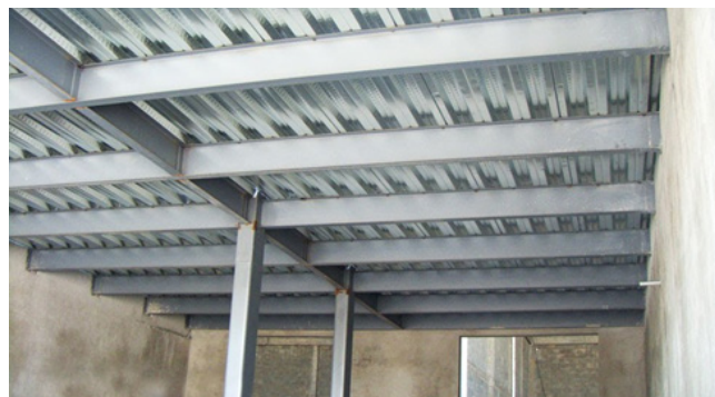
Ilustración 7 Losa Laminada acanalada
