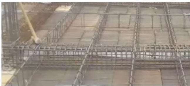
Figura 8 ejemplo de refuerzo de vigueta con estribos, refuerzo longitudinal superior e inferior.
