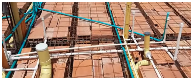
Figura 6 Malla electrosoldada en losa aligerada.
