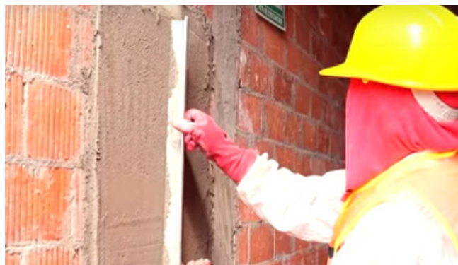
Figura 46. Aplanado del Muro
