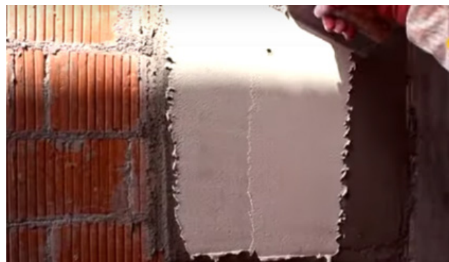
Figura 48. Aplicación del Estuco
