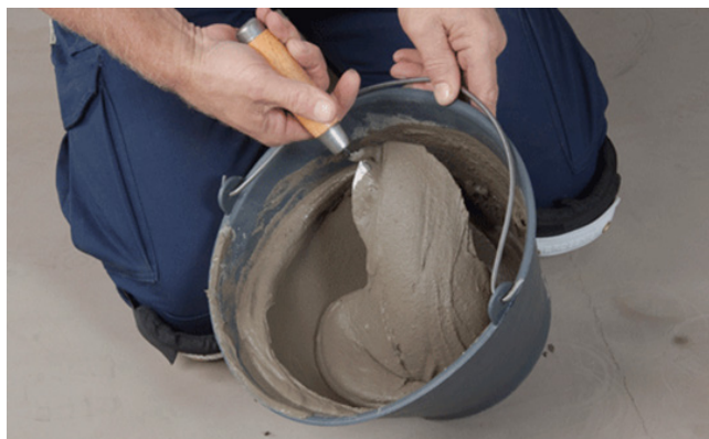
Figura 40. Mezcla de Adhesivo
