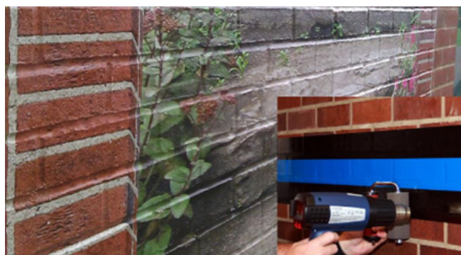
Figura 20. Vinilo en Muro Rugoso
