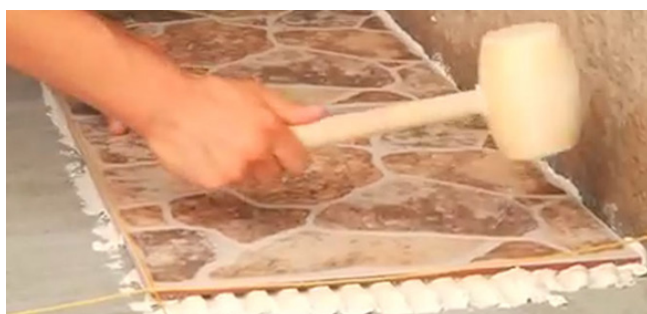
Figura 42. Colocación de Adhesivo
