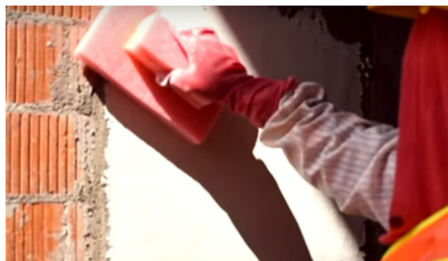
Figura 49. Alisado de la superficie
