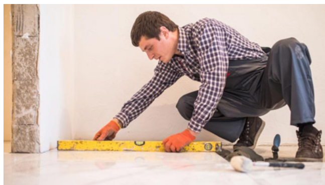
Figura 39. Nivelación de pisos
