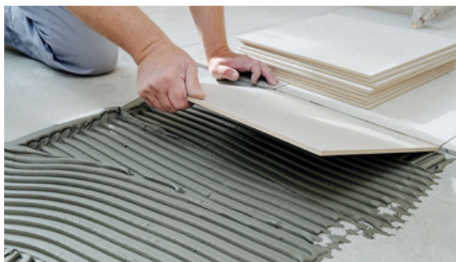
Figura 41. Aplicación de Adhesivo
