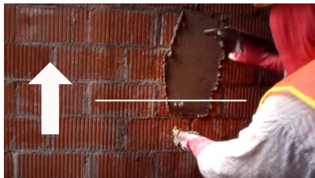
Figura 45. Aplanado del Mortero
