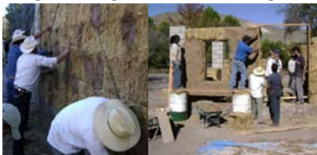
Figura 6. Revoque con Barro en muros de paca
