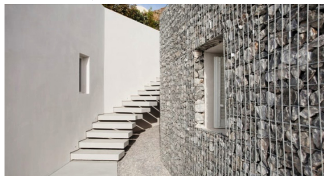
Figura 16. Muro de Gaviones
