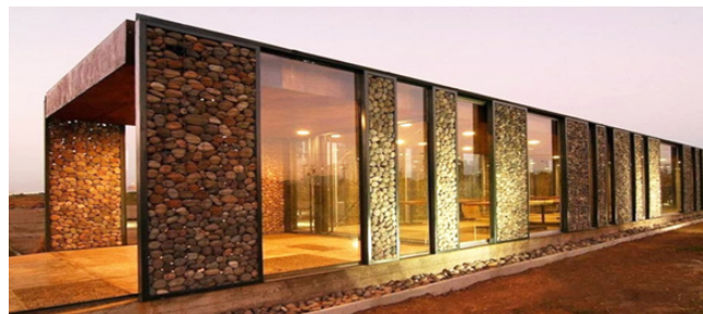
Figura 15. Muro de Gaviones
