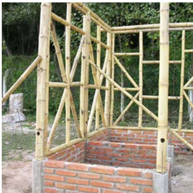
Figura 13. Estructura en Caña y fundaciones
