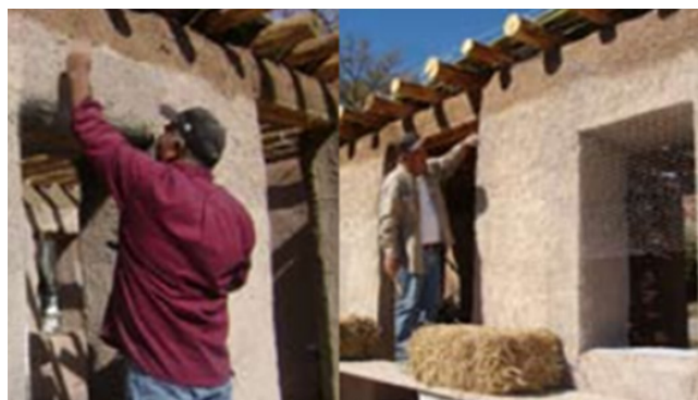
Figura 7. Terminado de muro con paca
