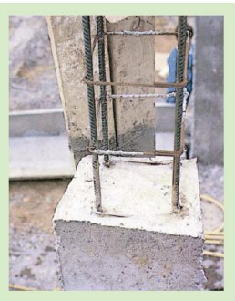
Armadura de pilar mal colocada. No oíó está girada sino que el exceso de recubrimiento provocará fisuras en el pilar cuando éste trabaje.
