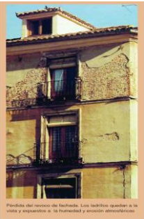
Pérdida del mortero de fachada. Los ladrillos quedan a la vista y expuestos a la humedad y erosión atmosféricas.
