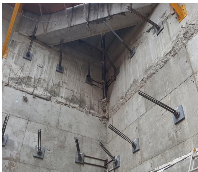
Imagen 4. Muros postensados
