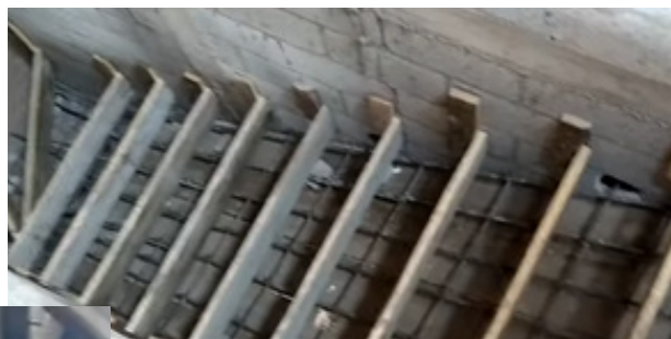
Figuras 17 y 18. Puntales en la losa
